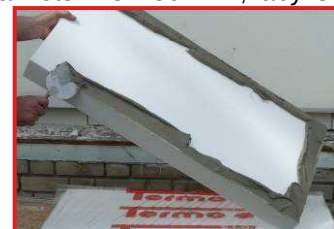
Vytvoření okrajového rámečku...
