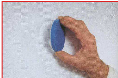
Plastový kotouč se vlepí do připraveného sedla pomocí tak, aby jeho povrch tvořil rovinu se zateplenou fasádou
