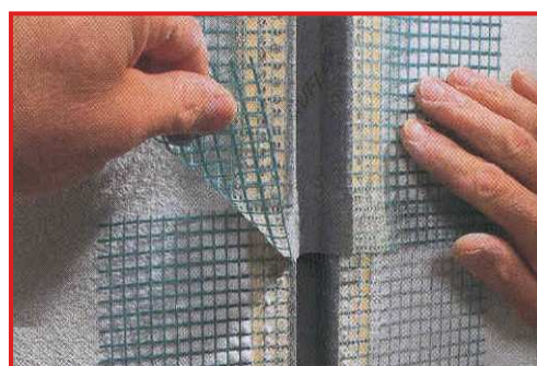
Montáž: Integrovanými pruhy síťoviny se profil napojí na okolní výztužnou vrstvu. Sousední profily se překládají shora dolů s přesahem 20 mm. Mezi plastovými částmi je nutné dodržet dilatační mezeru cca 3 mm.
