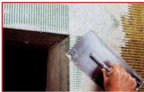
Obr.: Jako ochrana rohů se používá Sto-TermoPanzerwinkel nebo TermoWinkel
