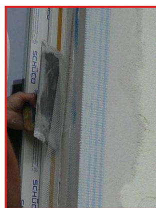
Nakonec se provede napojení integrovaného pásu sítě TermoApu Dynamik s ochranou rohu
