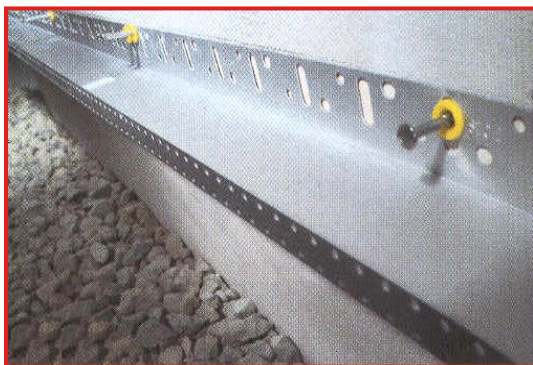
Zakládací lišta se připevní 3 ks/bm zatloukácích hmoždinek a vždy se přikotví konce profilů. Sousední lišty se spojí plastovou spojkou zabezpečující dilatační spáru.
