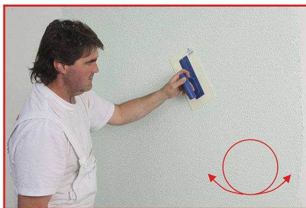
Strukturování: plastovým hladítkem se omítka nejdříve předtočí.
