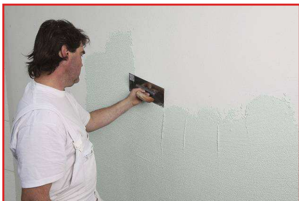
Nanesení omítky v tloušťce zrna. Důležité je, aby se přebytečné množství vždy odstranilo.
