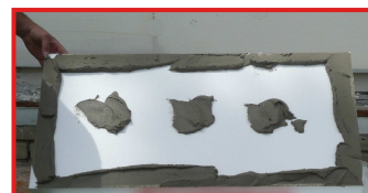
Nanesení stavebního lepidla bodově a po okrajích.
