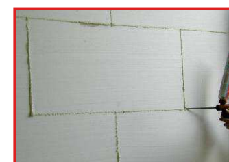
Otevřené spáry ve styku desek se pečlivě vyplní PUR pěnou.
