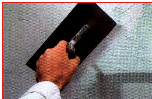
Obr.: Stěrkování: armovací hmota protlačená sítí se odstraní z povrchu
