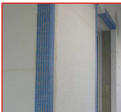
Obr.: Ochrana nároží objektu pomocí TermoPanzerwinkel .
