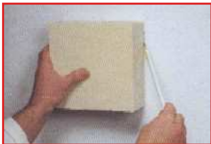
V místě umístění se tužkou vyznačí obrys hranolu...
