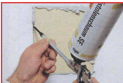
... a vloží se do vyříznuté kapsy, řádně se přitiskne k podkladu a obvodová spára se vyplní PUR pěnou...
