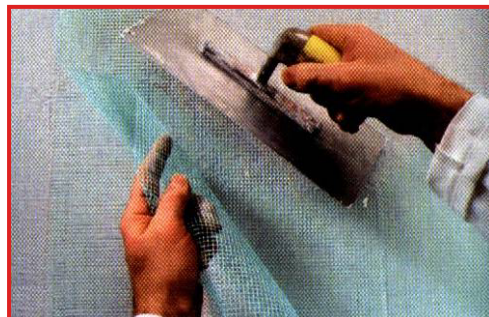
Obr.: Vložení síťoviny: Síť se zatlačí do čerstvé armovací hmoty, sousední pruhy se překryjí o 100 mm
