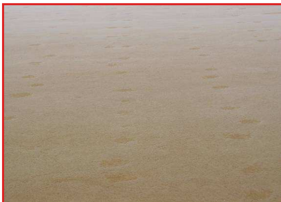
Obr.: Výřez fasády (štítu) objektu zatepleného ETICS s námrazou s viditelnými místy, kde jsou talíře plastových hmoždinek
