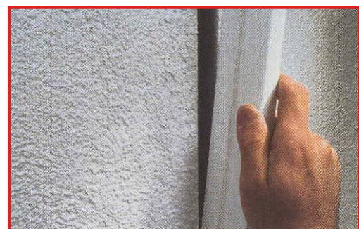
Povrchová úprava: Před nanesením omítky do profilu vložíme proužek polystyrénu, aby nedošlo ke znečištění manžety.
