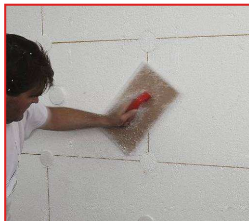
Krouživým pohybem brusného hladítka se zabrousí přesahy izolačních desek ve styčích.
