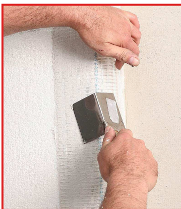
Ochrana rohu ostění pomocí a) TermoPanzerwinkel .
