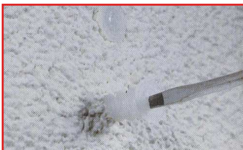
Spirálovou hmoždinku lze zašroubovat do zateplovacího systému přímo bez vrtání.
