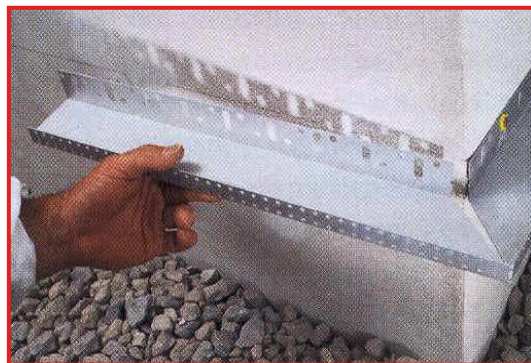
V liště se vyřízne rovnoramenný trojúhelník s vrcholem směřujícím k okapové hraně. Takto upravená lišta se ohne a připevní k nároží.
