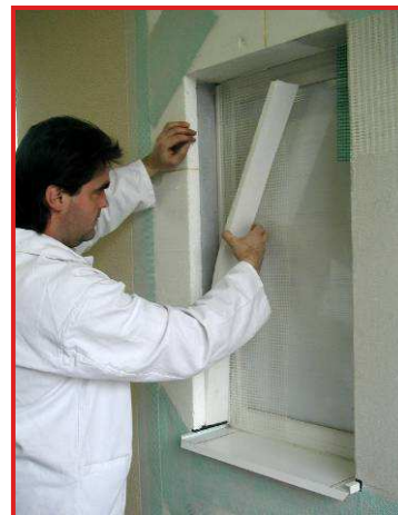
... připravené pruhy izolační desek k ostění a nadpraží
