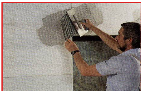
Obr.: Diagonální výztuha rozměru 200/400 mm v rozích otvorů.
